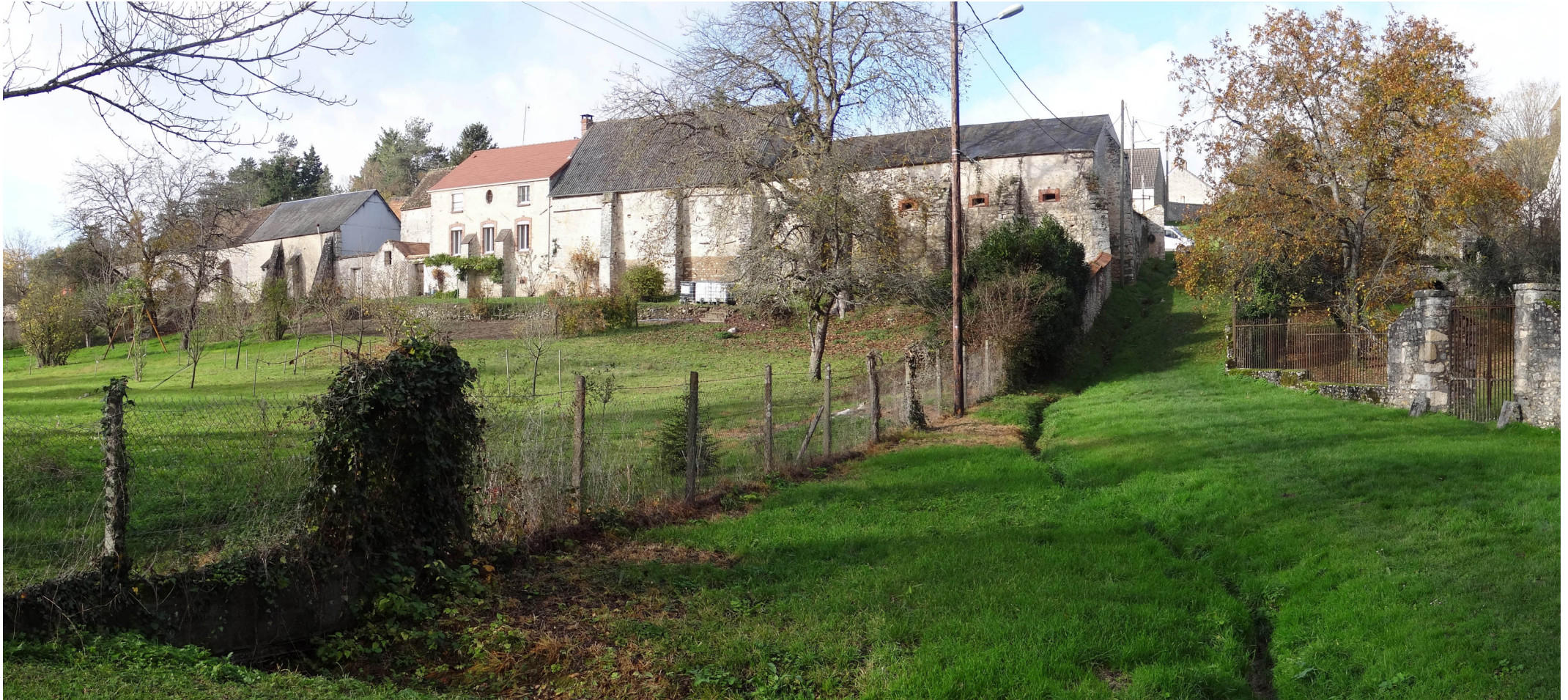
Chalou-Moulineux - Abords du lavoir [Fig.1]
