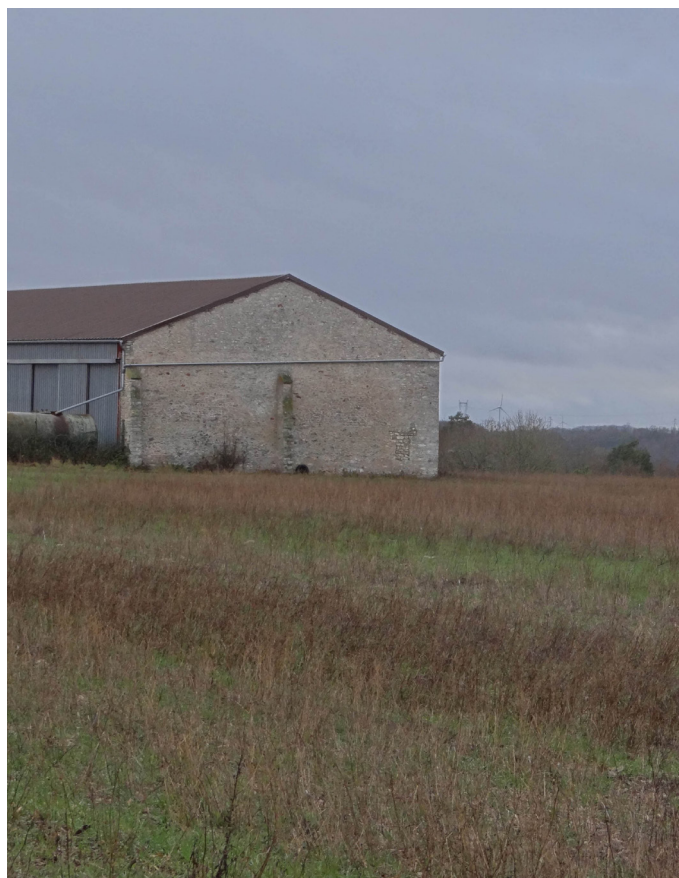
Châlo-Saint-Mars - Montoir de l'Entonnoir [Fig.2]
